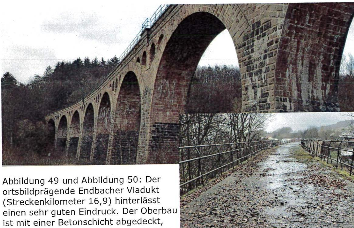
Abbildung 49 und Abbildung 50: Der ortsbildprägende Endbacher Viadukt (Streckenkilometer 16,9) hinterlässt einen sehr guten Eindruck. Der Oberbau ist mit einer Betonschicht abgedeckt, die Entwässerung ist funktionsfähig, es sind keine Risse o.ä. zu sehen, nur vereinzelte Versinterungen.
