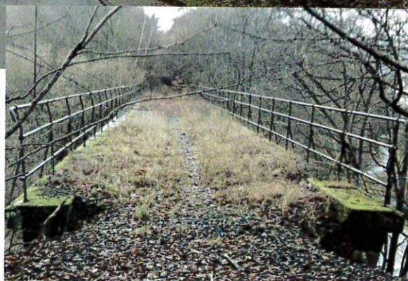
Abbildung 47 und Abbildung 48: Der Viadukt westlich des Haltepunktes Wommelshausen über die Straße „Am Wildbach“ (Streckenkilometer 16,5). Auf der Brücke befindet sich noch der Schotteroberbau. Trotz einiger Risse hinterlässt das Bauwerk einen befriedigenden Eindruck.
