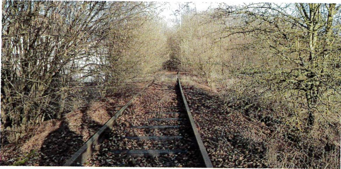
Abbildung 20: Im Bereich der Ortslage Niederwalgern ist das Streckengleis noch vorhanden, aber zugewachsen, die Schotterbettung des Bahndamms selbst stark vererdet.
